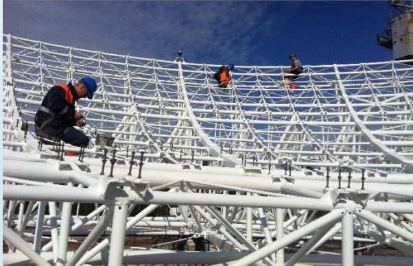
Distanceru krásošana Al paneļu montāžai, RT-32, 2015/ Painting of adjusters for Al panels, RT-32, 2015
