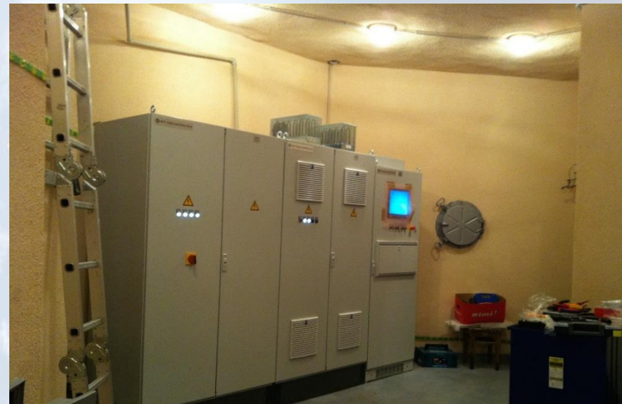
RT-16 mašīnzāle ar tiko uzstādītiem jaunajiem vadības un piedziņas sistēmas blokiem, 2015/ Control room of RT-16 with newly installed components of control and drive systems, 2015
