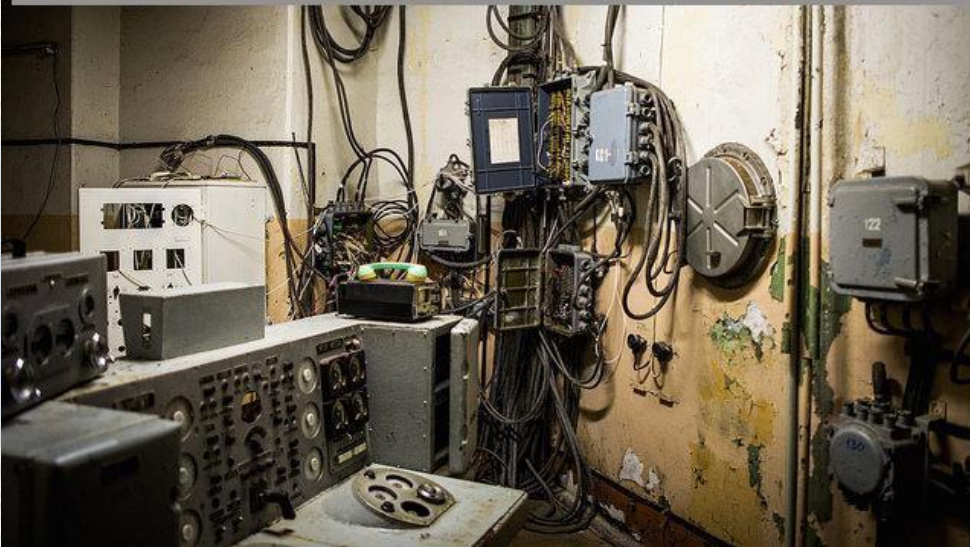
RT-16 mašīnzāle pirms modernizācijas, 2014./ Control room of RT-16 before modernisation, 2014
